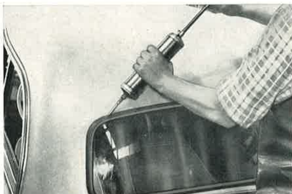
Bild 584: Die Gummifassung wird schließl. zur Karosserie und zur Scheibe hin mit Dichtungsmasse ausgespritzt.
