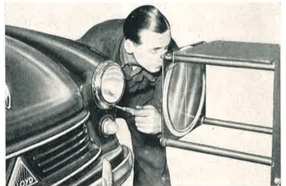
Bild 54 a/2: Einstellen d. Scheinwerfer am Einstellgerät.
