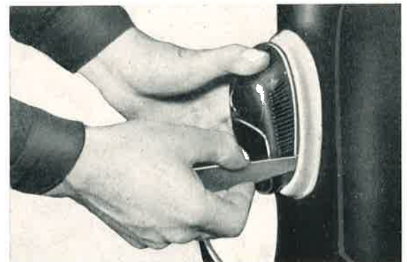
Bild 54 a/4: Die Kunstharzdeckel der kombinierten Schlußleuchten werden mit einem Falzbein eingesetzt.
