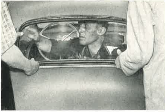
Bild 581: Die mit Gummifassung versehene Scheibe wird von unten nach oben zunächst eingeführt u. angedrückt.
