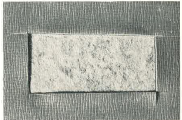
Bild 672: Mit einem scharfen Messer wird ein entsprechendes Stück in passender Form sauber ausgeschnitten.
